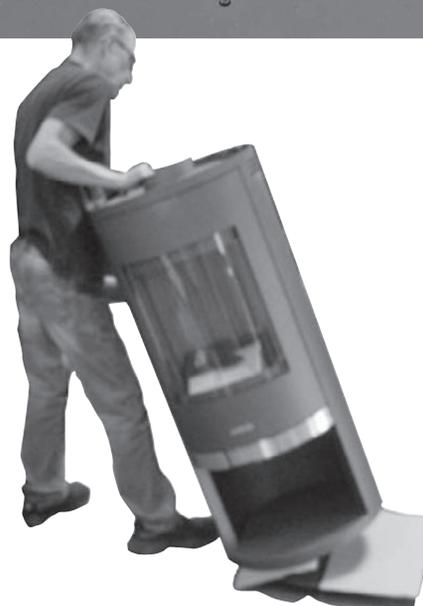
**Schritt 4.** Der Kaminofen ist zentrisch auf dem Dreh-Tableau zu positionieren.
