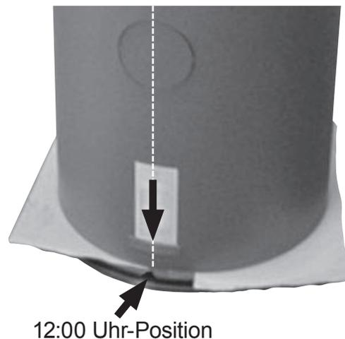
**Schritt 5.** Mit einem spitzen Gegenstand durch die Bohrungen im Bodenblech des Ofens durchtasten um die Gewindebohrungen im Dreh-Tableau zu finden und den Ofen fein auszurichten und 1 Schraube einsetzen und etwas andrehen. Noch nicht festziehen!
