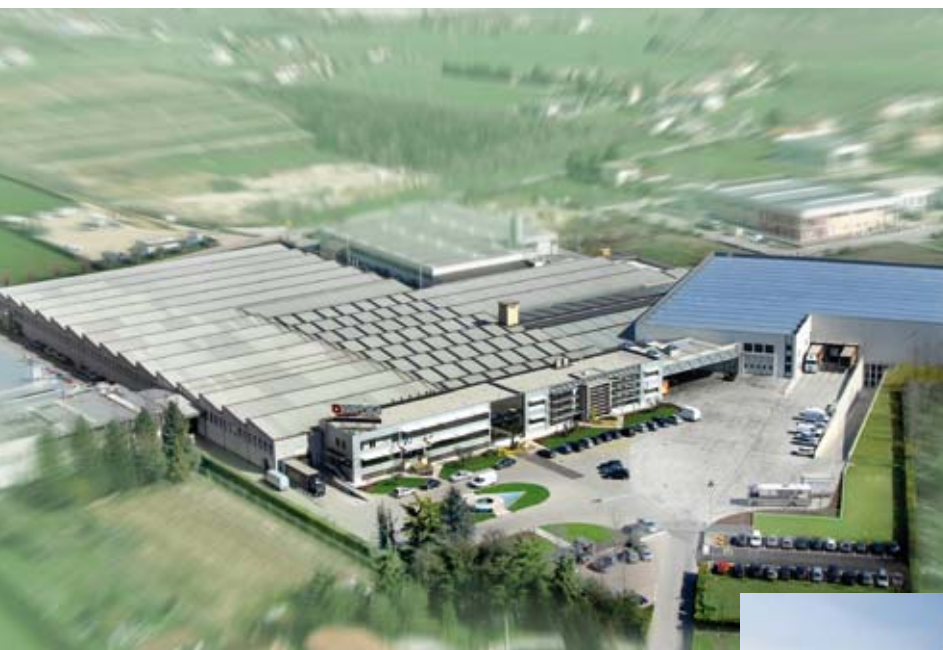
Stabilimento La Nordica Montecchio Precalcino
