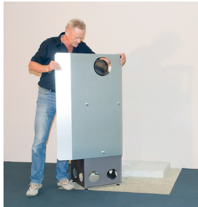
Wärmeschutzblech (Zubehör) montieren
