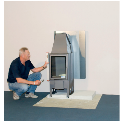
Kamineinsatz mit Wasserwaage einrichten
