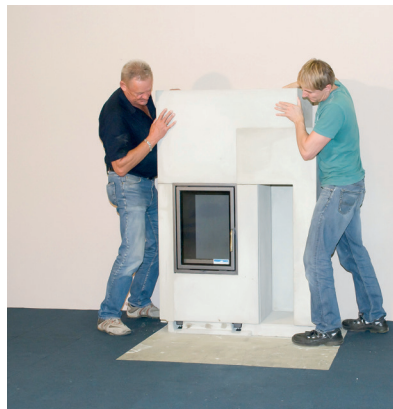
Verkleidungselemente Stück für Stück zusammensetzen und verkleben
