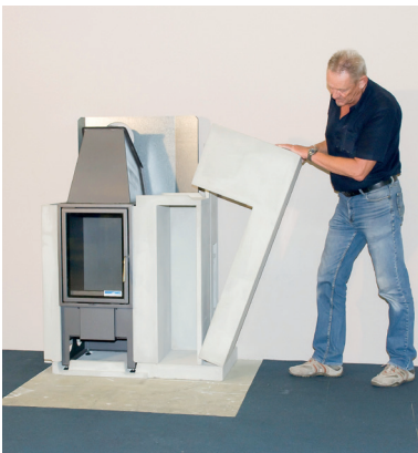
Verkleidungselemente Stück für Stück zusammensetzen und verkleben
