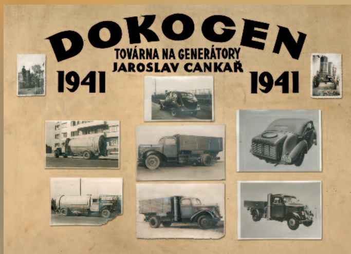
Produktion und Endfertigung von Holzvergassergenerator
